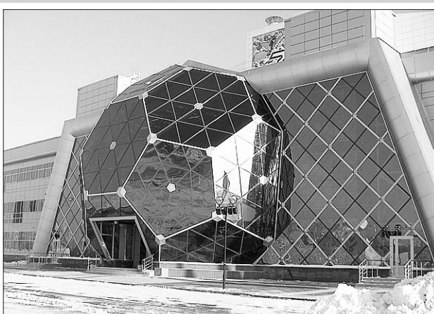
28 ноября 2011 года. Открылся уникальный крытый футбольный манеж, расположенный на ул. Колыхидской. В здании большое футбольное поле с искусственным покрытием и трибунами на 3500 мест.
